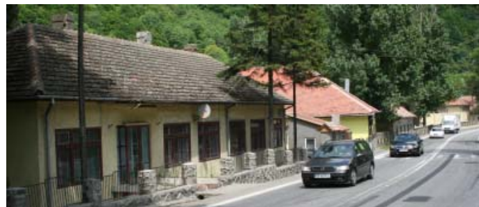
Enkele gebouwen van de instelling in Lazaret
